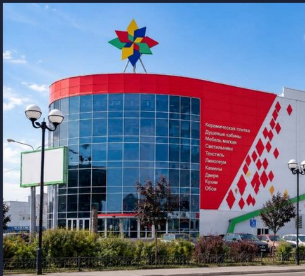
Досуго-развлекательное здание, 2014, г. Новосибирск
